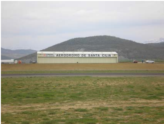
Hangar situado al otro lado de la pista
